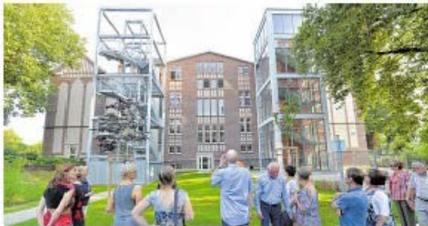
Zwei Treppenhäuser wurden dem Gebäude beim Umbau vorgelagert, eines hat einen Aufzug.
