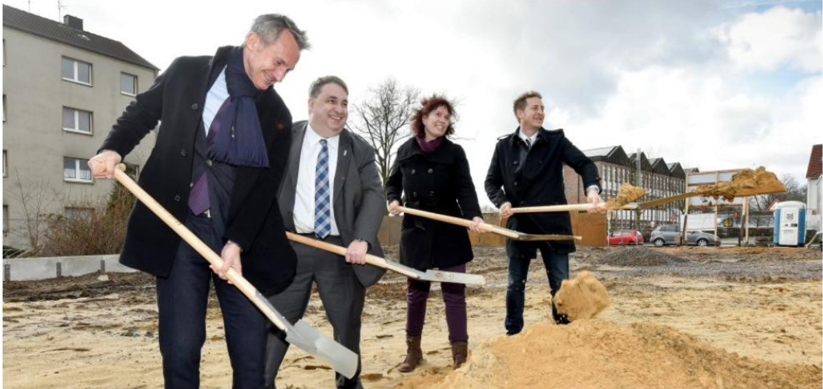
Oberbürgermeister Frank Baranowski (v.l.), ggw-Geschäftsführer Harald Förster, Sandra Wessels vom Architekturbüro und Generalunternehmer Frank Uhlig beim ersten Spatenstich am Erlenbruch 11.
